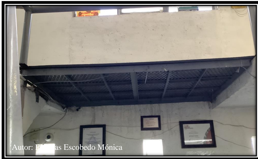
Figura n. ° 46 Pasillo y barandal
